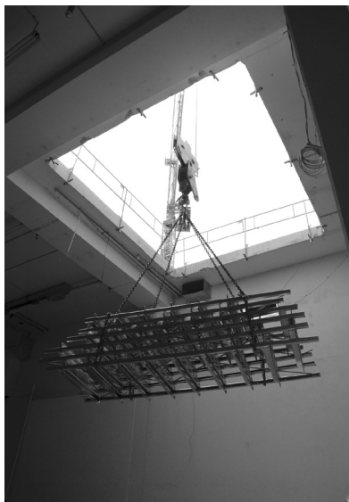
Extraction des rails du robot. © Ville de Bordeaux – Valérie Daviet
