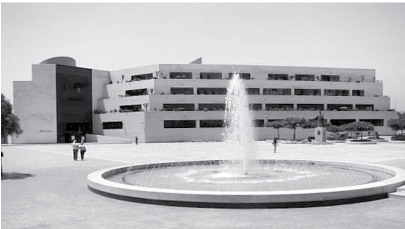
Le nouvel édifice de la bibliothèque Pedro-Zulen (bibliothèque centrale de l'UNMSM). Photo : David-Jonathan Benrubi
