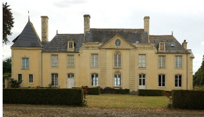
Figure 1. Le château de Villeray dans la commune des Moutiers-en-Cinglais (Calvados), XVIII e siècle
