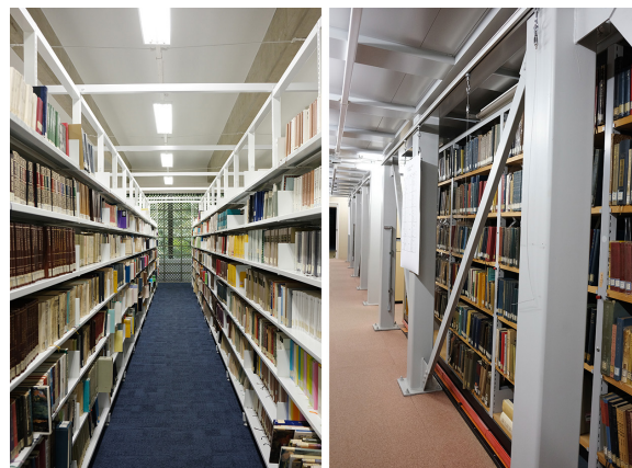
Figure 4. La bibliothèque universitaire du Tōhoku, à Sendai. À gauche : rayonnages en libre accès avec fixations murales et avec structure renforcée (au fond, croisillons). À droite : rayonnages en magasin, structures renforcées
