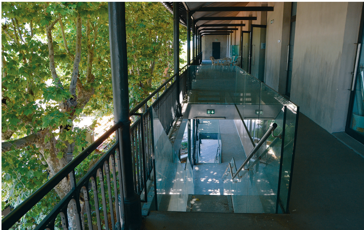
Sur un balcon du bâtiment de Copeia.
