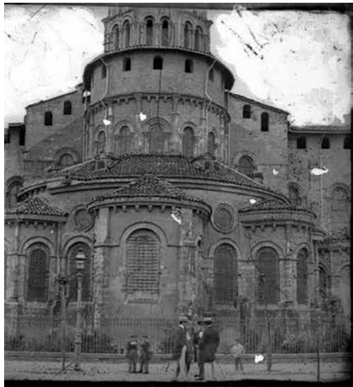
La basilique Saint-Sernin en cours de restauration entre 1870 et 1880. Photographie du fonds Eugène Trutat, archives municipales de la ville de Toulouse.
