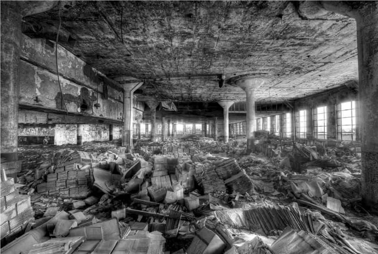
Le dépôt de livres de la Detroit Public School abandonné après un incendie survenu en 1987. Photo : Shane Gorski (country_boy_shane) sur Flickr (licence CC-by 2.0)
