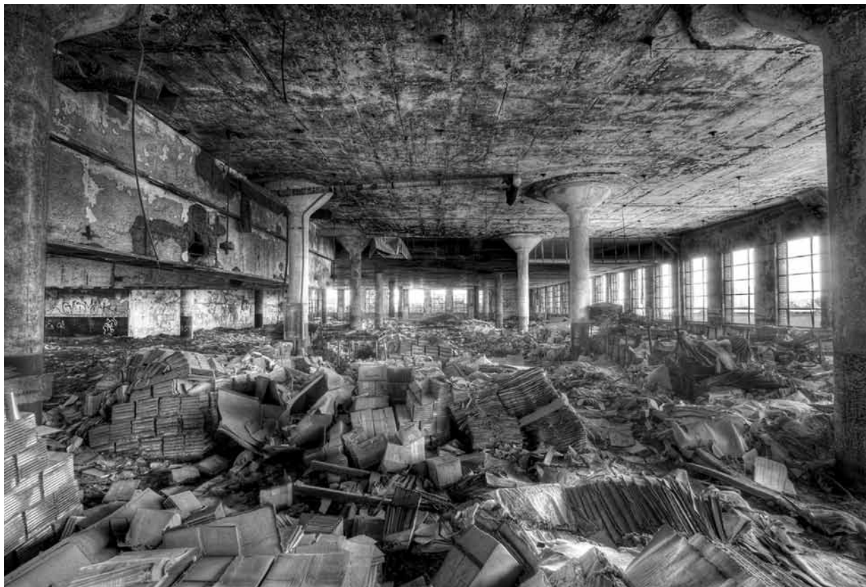
Le dépôt de livres de la Detroit Public School abandonné après un incendie survenu en 1987.
