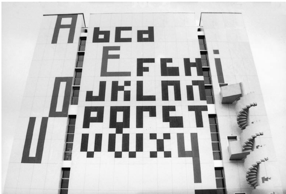
Détail de la façade de la bibliothèque de lettres et sciences humaines. © Université Michel de Montaigne Bordeaux 3
