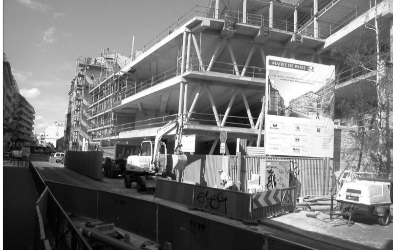
Chantier de la médiathèque Marguerite Yourcenar. © Photo: Jacques Cuzin
